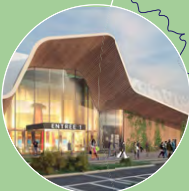
Extension-rénovation du centre commercial Ermont
